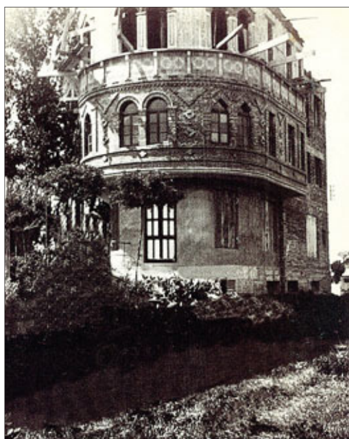
Foto sin datar, en plena construcción de la casa.
